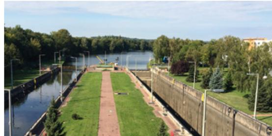
rende Kammer zum Unterwasser hin abgelassen und die talfahrende Kammer wird vom Oberwasser her aufgefüllt.
