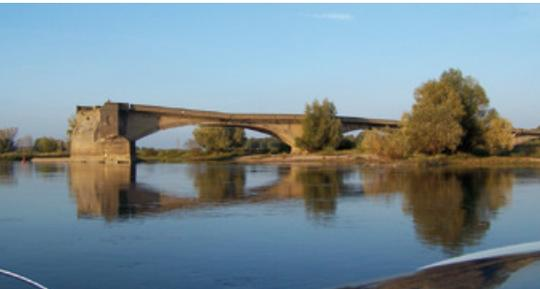
Unweit des Fürstenberger Stadions befinden sich bei Stromkilometer 552,13 am rechten Ufer die Reste der Fürstenberger Oderbrücke. Am 12. September 1919 wurde sie nach fünfjähriger Bauzeit eingeweiht. Das Stahlbetonbauwerk besaß eine Länge von 626,3 Metern, die Fahrrinne überspannte ein eleganter 103,5 Meter langer und 11,9 Meter hoher Stahlfachwerkbogen. Am 4. Februar 1945 wurde die Brücke durch die Deutsche Wehrmacht gesprengt, um den Vormarsch der Roten Armee über die Oder zu behindern.
